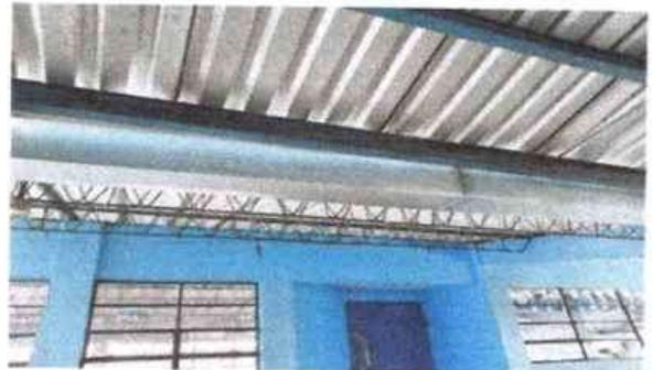
Foto 4: Canal de metal sustituido.
