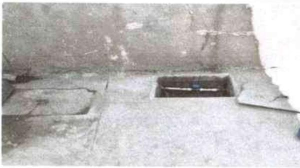
Foto 9: Red de drenaje y de caja agua potable reparado.
