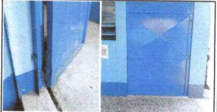
Foto 2: cambio de marco, soldadura, lijado en la parte inferior de puerta y pintura de puertas de metal.
