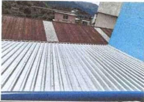
Foto1: Lámina sustituida.
